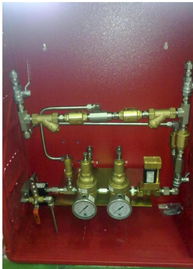
Sistema di pilotaggio della Idrovalvola
