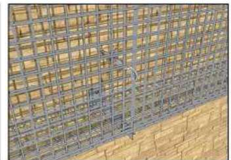
DETTAGLIO STAFFA FISSAGGIO SUPERIORE
