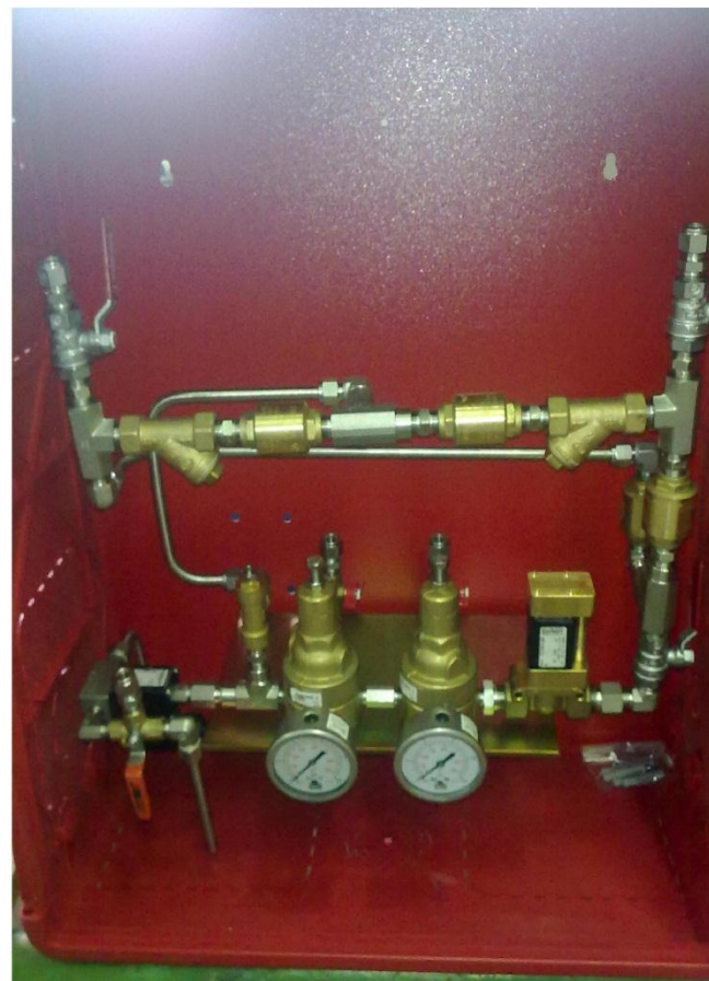
Sistema di pilotaggio della Idrovalvola
