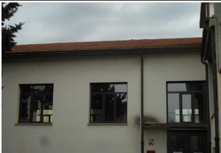
Copertura della palestra verso la scuola
