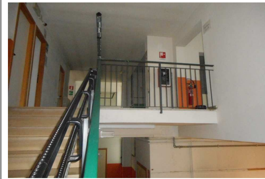
Scala nella palazzina dei servizi
