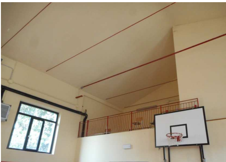
Veduta dei tiranti della copertura
